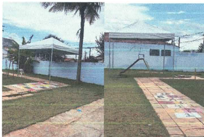
Instalação das tendas, parte externa
